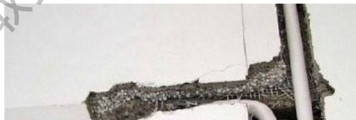
图 3-16（自摄）“东方明珠”小区住宅墙体内保温断面。 那一粒粒白色的东西就是保温胶浆的显著标志——苯板颗粒。
