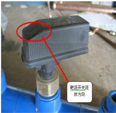
错误的安装方式：方向错误
