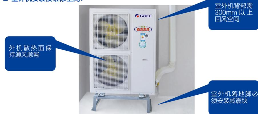
注：外机换热不畅时，制冷时易出现高压保护，制热时易出现低压保护。
