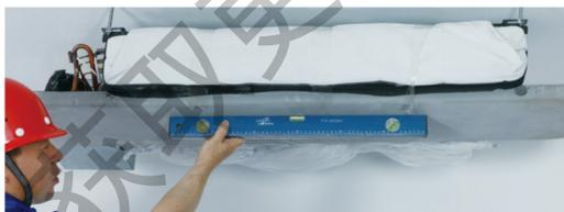
注意：内机吊装完毕后，要包好防止装修时灰尘落入机器内部。
