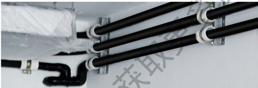
注意：室内机冷凝水管吊装完毕后，需进行试水试验，确保内机排水通畅。
