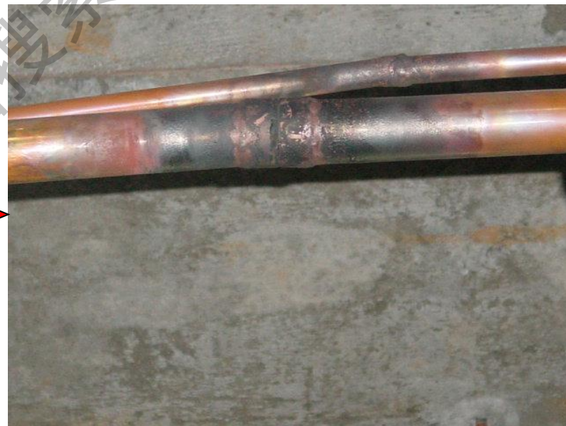
同管径胀管连接
