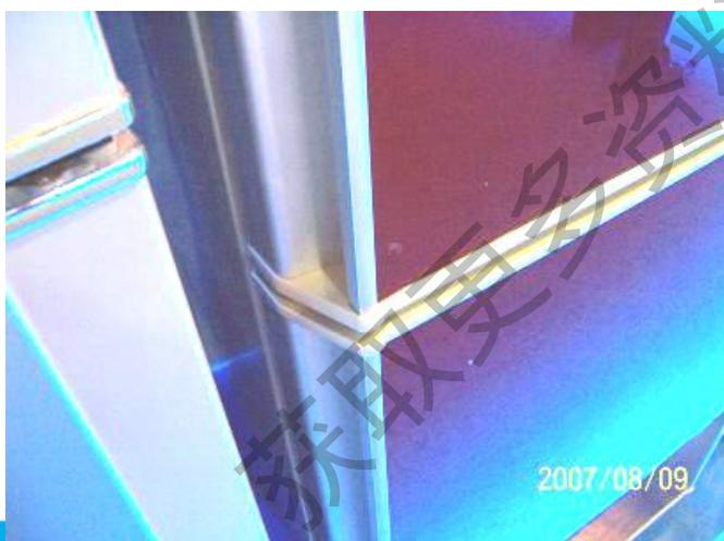
端盖与立柱的配合结构有拼接和套接两种，多段连续弧面的拼接在制件要求和工艺控制上难度大，接缝不齐和接合面台阶是主要外观问题
