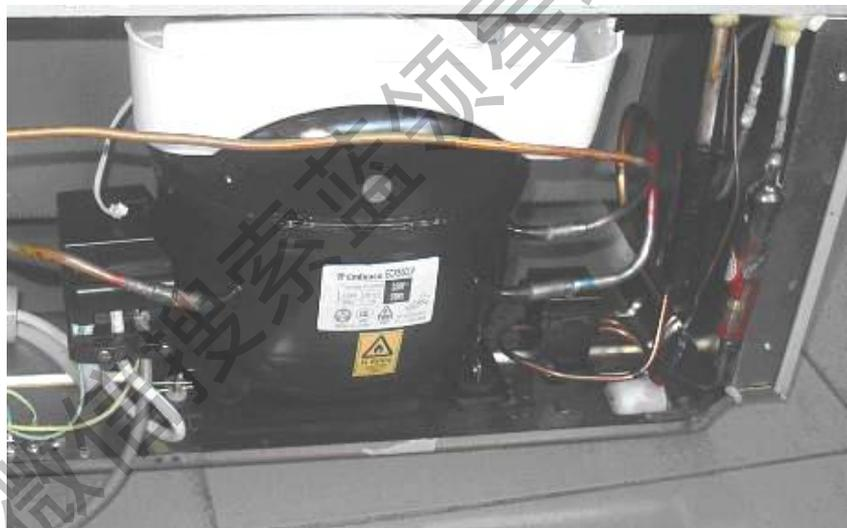
冷藏室内的水汽遇冷藏室蒸发器后，在箱胆壁上凝结而形成薄霜，压缩机停机时，箱胆表面的薄霜融化后沿排水管流入接水盘，压缩机开机时，利用压机自身的热量将盘中的冷凝水蒸发。接水盘应有足够的容积，并离压缩机体足够近，且保持空气对流畅通。
