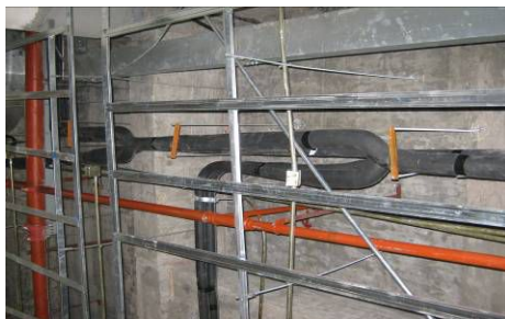
室内分歧管使用 U 型分歧管（正确）
