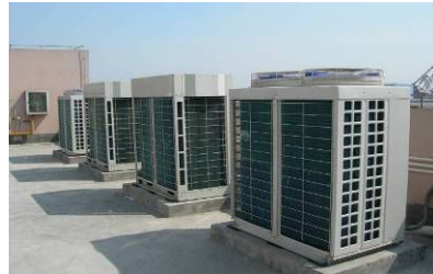
外机散热效果好（正确）
