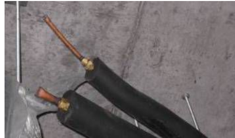
管路施工完成后要对管路进行封口处理，焊封或是用胶布封口（好）
