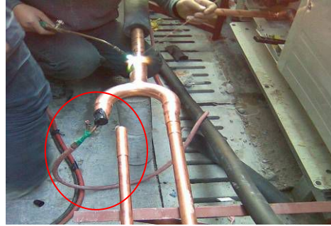
充氮气保护，避免产生氧化皮（正确）
