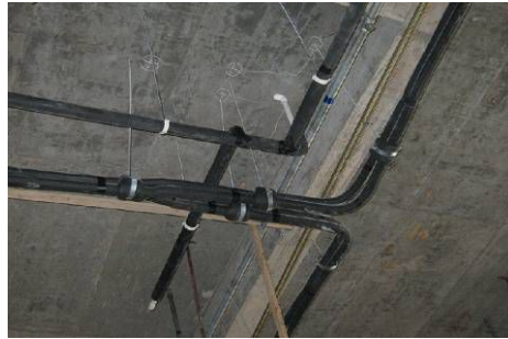
吊杆间距符合要求（正确） （间距在 1~1.5m）
