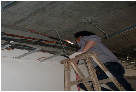
铜管焊接时没有充氮气保护（错误）
