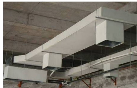
送、回风管安装规范，送回风顺畅 （正确）
