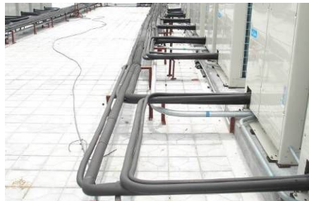
室外机分歧管安装规范（正确）
